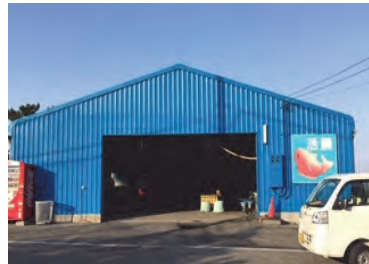
活魚棟。活魚販売が特色の直売所。一般消費者だけでなく業者も買い付ける。施設内の食堂で提供する活魚料理目当ての客も多い。
